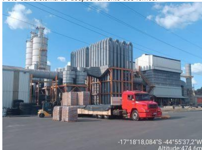
Foto 02: Sistema de despoeiramento dos fornos.
