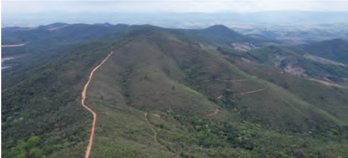
Foto 4-12 Estrada não pavimentada na borda da RPPN com pequenos focos erosivos.
