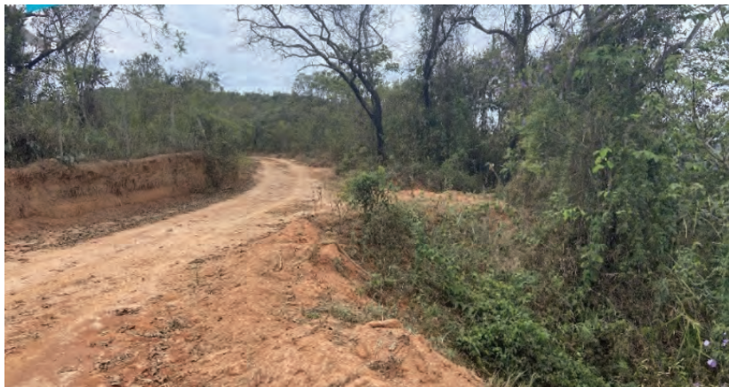
Foto 4-23 Acúmulo de sedimentos nas laterais do acesso com deslocamento para as partes mais baixas do relevo
