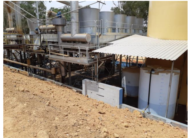
Figura 06. Aerocondensadores
