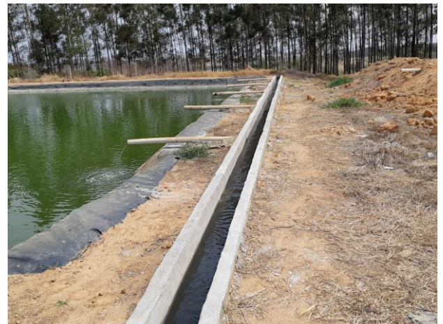
Figura 10. Lagoa de tratamento
