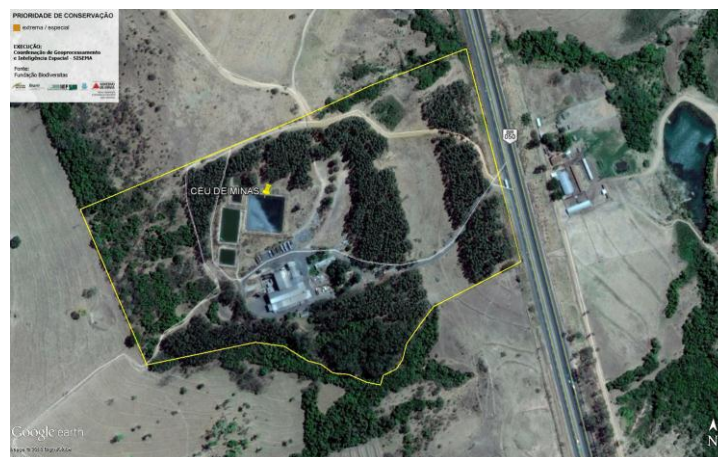
Figura 01. Vista aérea do empreendimento Fonte: Google Earth (08/08/2018)
