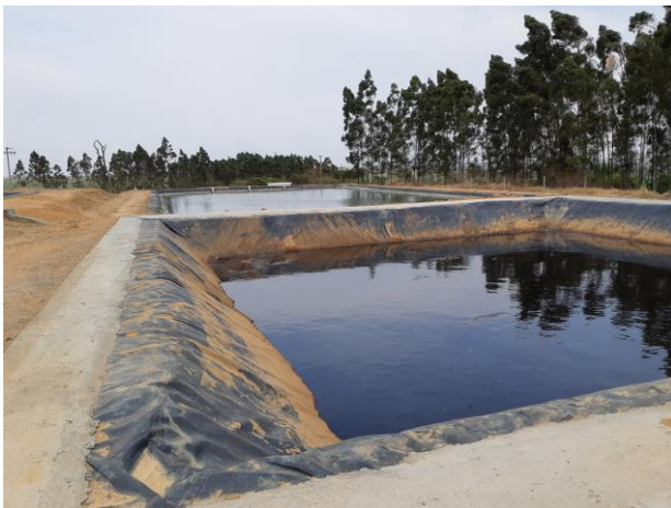
Figura 09. Lagoas de tratamento
