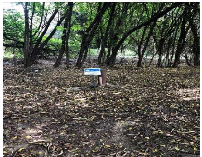
Poço de monitoramento (Montante)
