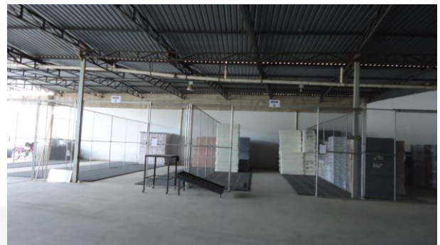
Foto 06. Armazenamento do Produto Final.
