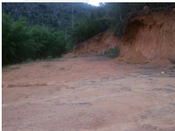
Foto 03. Área do canteiro de obras.
