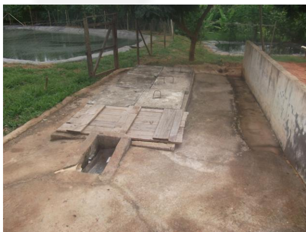
Foto 03. Vista do sistema de tratamento de efluentes
