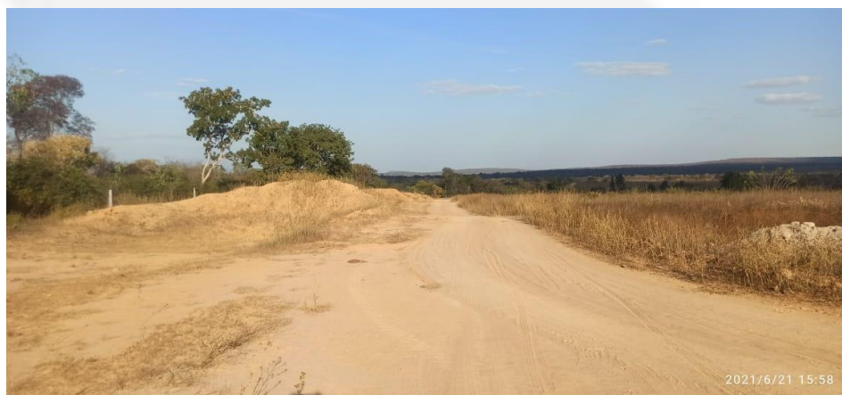
Foto 03: Bacia de contenção e drenagem
