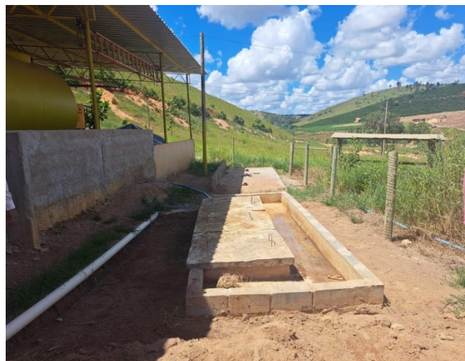
Foto 06 – Ponto de abastecimento (à esquerda) e sistemas de tratamento de efluentes líquidos (caixa SAO e fossa/filtro), ambos com lançamento em sumidouro.
