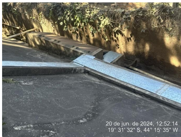
Foto 56: CSAO da empresa, responsável por separar efluentes advindos de todo o complexo da oficina mecânica, sendo: Oficina mecânica, lavador de veículos, sala dos compressores, armazenamento de resíduos classe I, posto de combustível, almoxarifado e todas as áreas de manutenção
