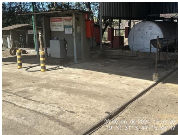
Foto 78: Área de abastecimento de veículos
