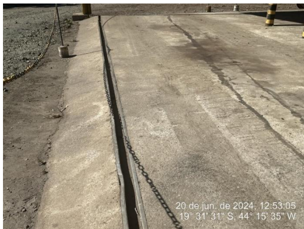
Foto 77: Canaleta na área de abastecimento de veículos
