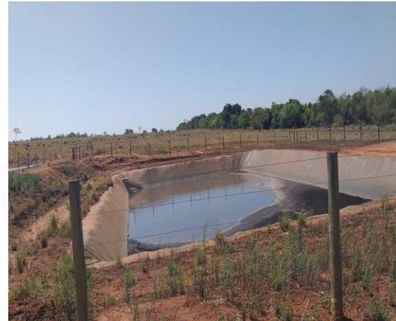
Foto 02. Lagoa de estabilização
