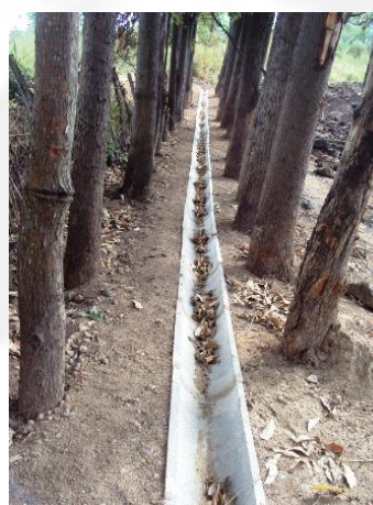
Fotos 09 e 10. Drenagem de água pluvial
