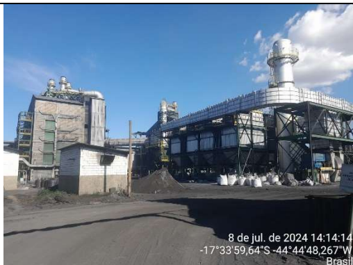
Foto 01: Fornos Elétricos a Arco e seu sistema de despoeiramento
