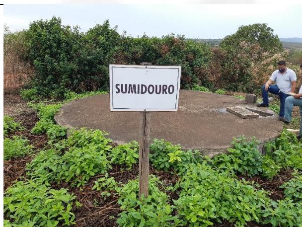
Foto 12. Sumidouro para destinação final dos efluentes tratados
