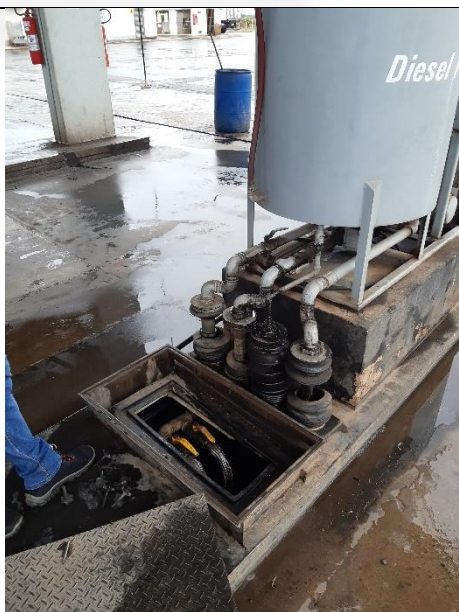
Foto 05. Filtro de diesel com sump
