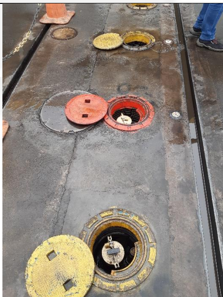
Foto 03. Área de descarga de combustíveis com sump e sistema para descarga selada
