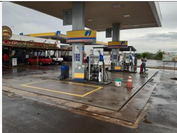
Foto 02. Pista de abastecimento com canaletas
