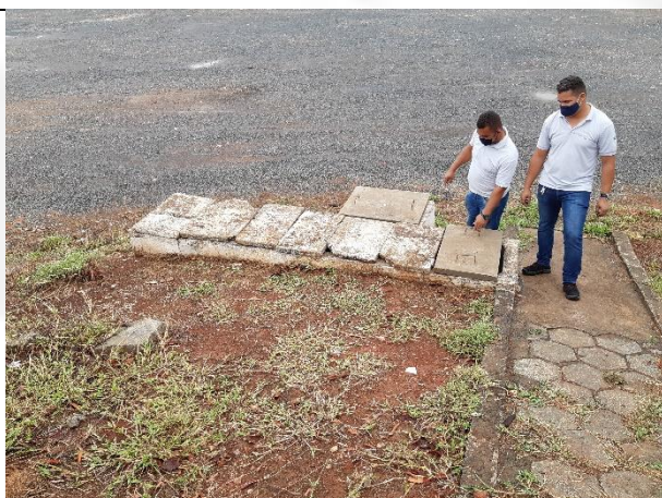
Foto 11. Caixa separadora de água e óleo
