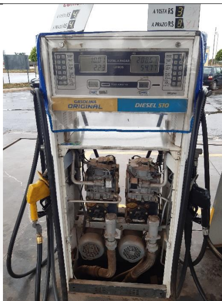
Foto 06. Bomba de abastecimento com check-valve e sump
