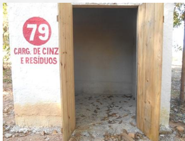
Foto 08. Barracão para armazenagem de cinzas da área de queima.
