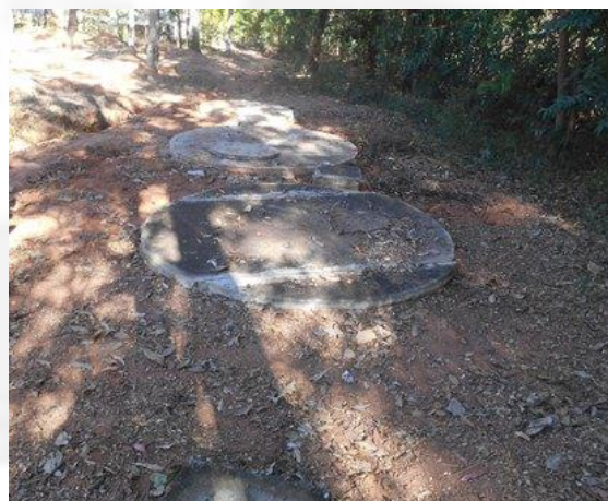
Foto 04. Estação de tratamento de efluentes sanitários.
