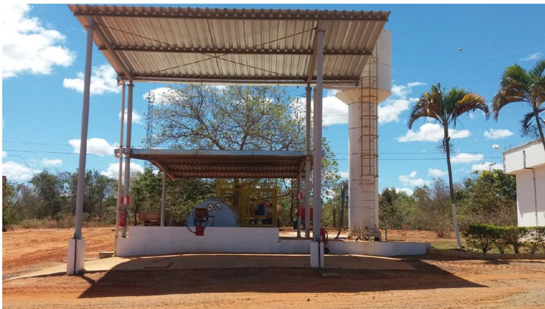
Figura 2. Pista de abastecimento de veículos com sistema de drenagem direcionado para a caixa separadora de água e óleo
