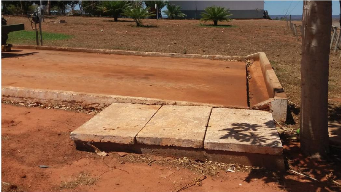
Figura 1. Área de estacionamento de máquinas e implementos agrícolas com sistema de drenagem direcionado para a caixa separadora de água e óleo.
