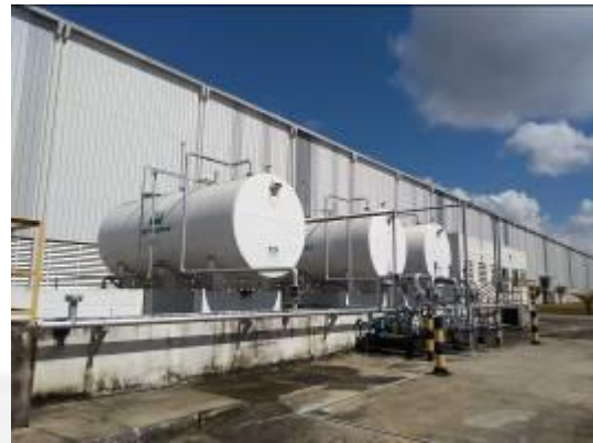
Foto 07. Armazenamento de combustíveis
