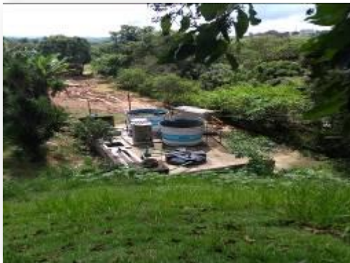
Foto 03. ETE Sanitária Norte/Apartamentos
