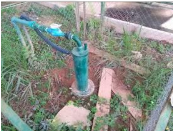
Foto 09. Poço tubular em regularização
