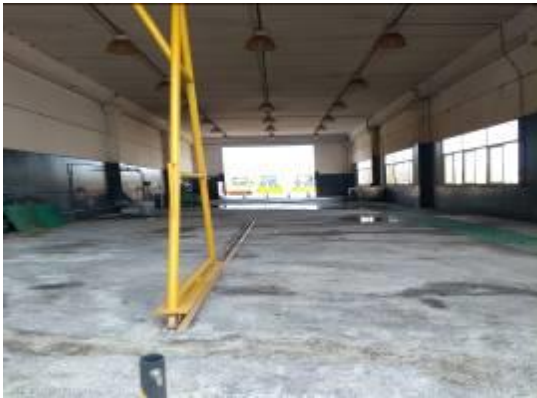
Foto 06. Galpão de lavagem de equipamentos
