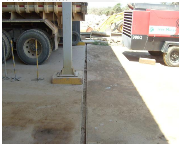
Foto 07: Área de manutenção devidamente instalada
