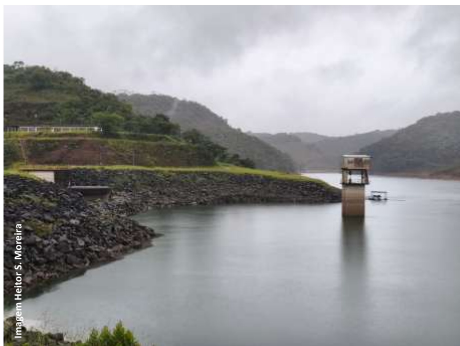
Barragem Chapéu D'Úvas – Ewbank da Câmara - MG.
