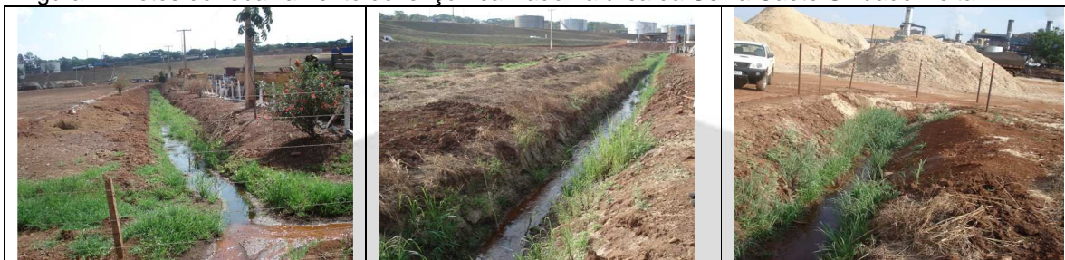
Figura 1 – fotos do rebaixamento do lençol realizado na área da Usina Caeté Unidade Delta.
