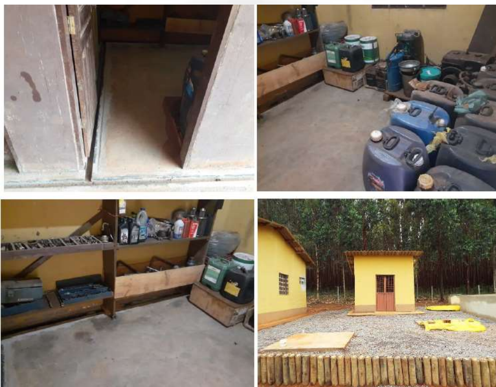
Figura 10. Galpão de armazenamento temporário de resíduos perigosos.
