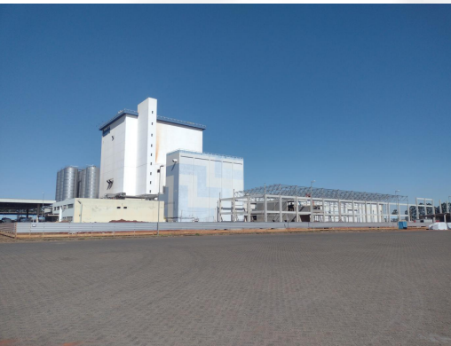
Área da futura fábrica de queijos
