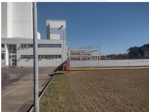
Área da futura fábrica de queijos
