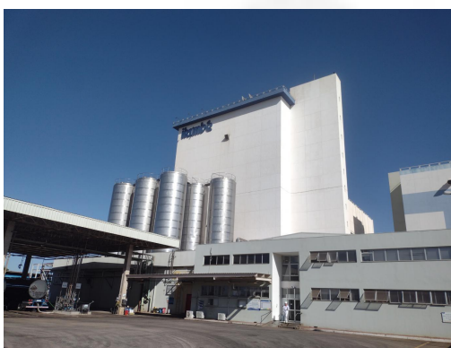
Instalações industriais existentes
