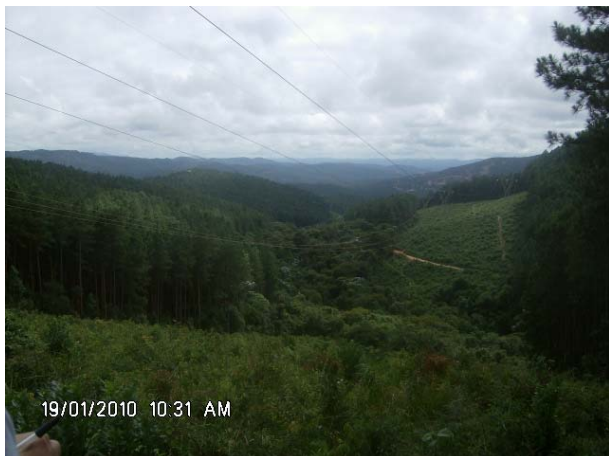
Foto 01. LT 230kV Taquaril/Itabira2 no trecho a ser seccionado pela SE Chaveamento
