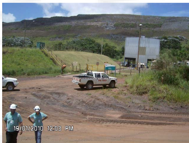
Foto 04. Vista ampla da área de implantação da SE Conceição (ITM Pellet Feed)
