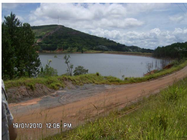
Foto 03. Vista ampla (sentido ré) do local de implantação da T-10, próximo à SE Conceição
