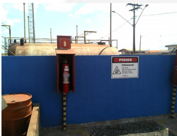
Foto 05. Bacia de Contenção do Tanque de Diesel
