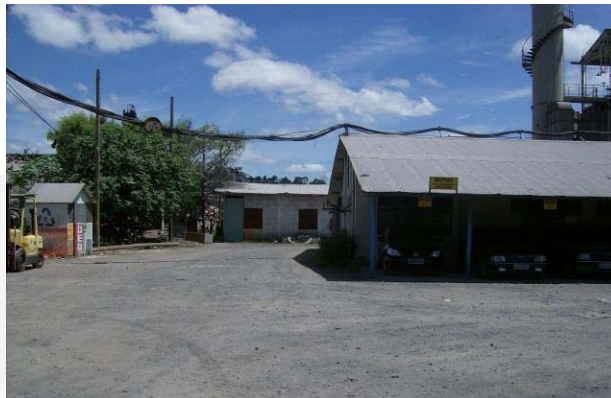
Foto 02. Vista da área da subestação de energia elétrica.
