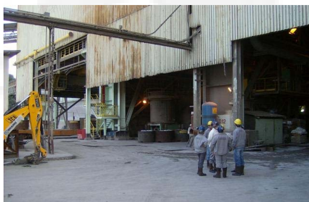
Foto 04. Vista da área em que se dará a ligação do novo galpão com os novos equipamentos e o galpão existente.
