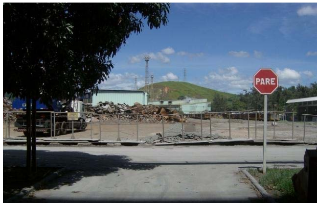
Foto 01. Vista da área do pátio a ser instalado o forno panela e o RH.
