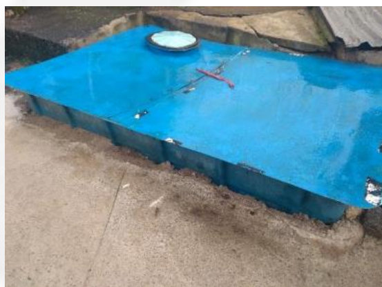
Figura 3: Caixa recebimento do sangue (neste ponto é realizado o bombeamento e captação do sangue a ser destinado)
