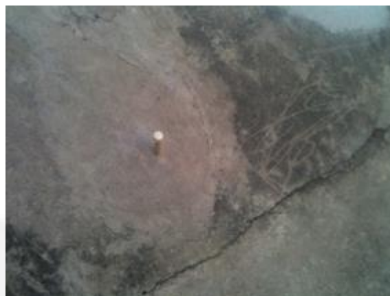
Foto 18: Poço tubular tamponado.
