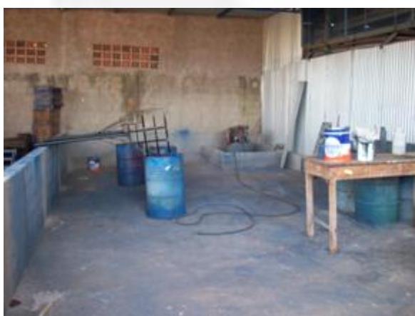
Foto 21: Área de pintura de equipamentos.
