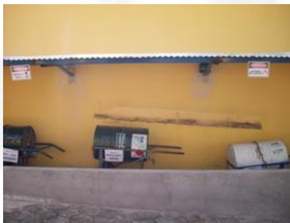
Foto 4: Depósito de insumos químicos.
