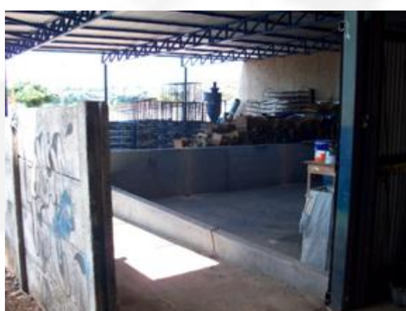
Foto 22: Área de pintura de equipamentos.
