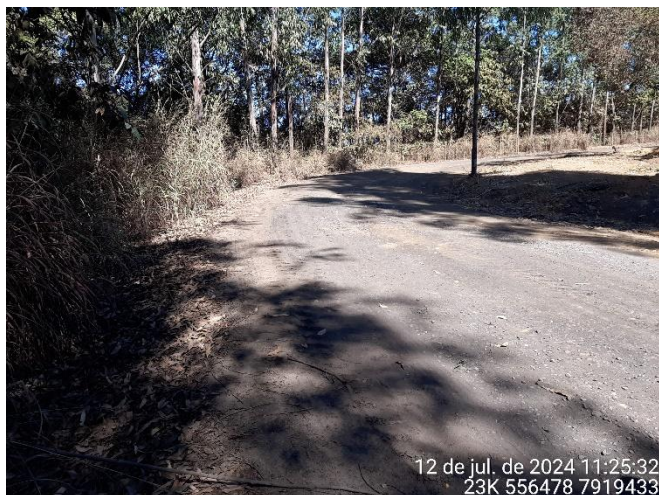
Foto 33: Lateral do acesso com caimento e canaleta escavada que direciona o efluente para o sump localizado dentro da reserva legal.
