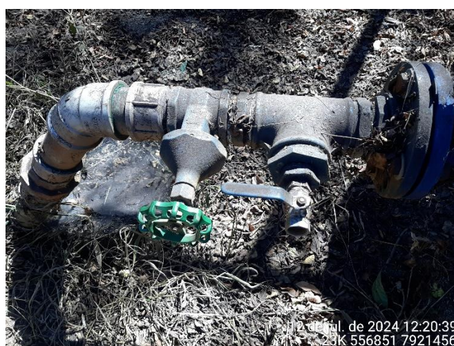
Foto 94: Torneira de monitoramento do poço 01.
