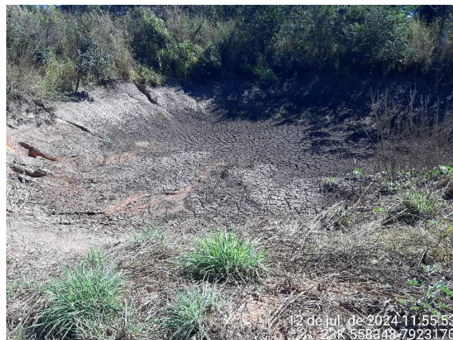
Foto 32: Bacia de decantação localizada nas proximidades das coordenadas UTM 23k 556551 / 7919805 que recebe todo o escoamento de drenagens superficiais do empreendimento.
