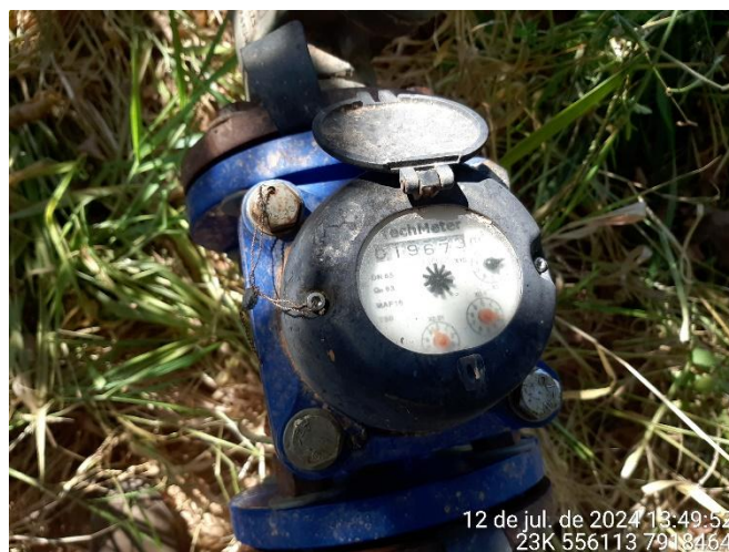
Foto 100: Hidrômetro do poço 02.
