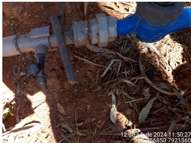
Foto 104: Torneira de monitoramento do poço 03.
