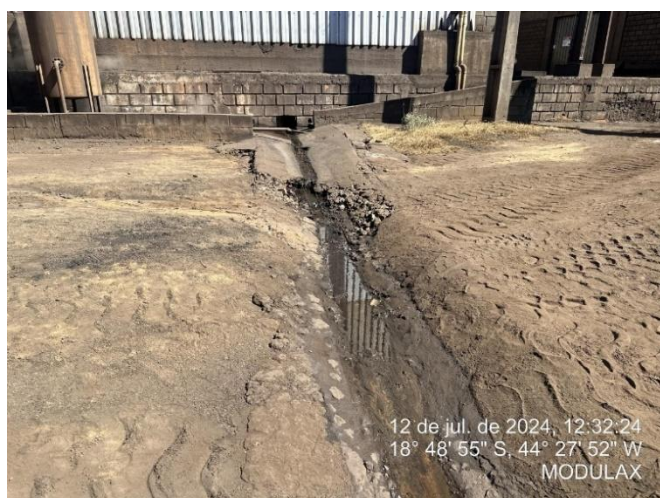
Foto 27: Canaleta com avaria próximo à termelétrica.
