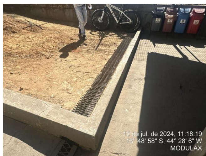
Foto 22: Canaletas de drenagem localizadas na portaria
