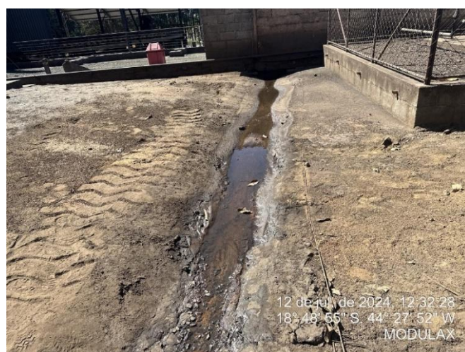
Foto 28: Canaleta com avaria próxima à termelétrica
