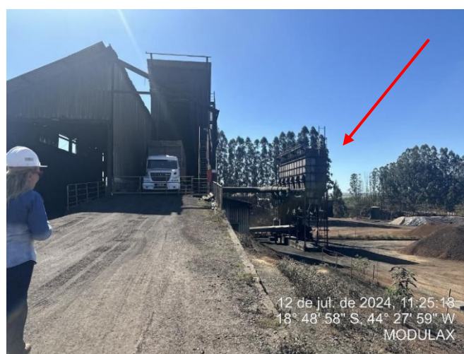
Foto 16: Galpão de carvão. Seta evidenciando filtro de mangas associado à descarga
