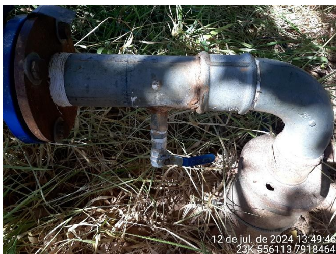
Foto 99: Torneira de monitoramento do poço 02.
