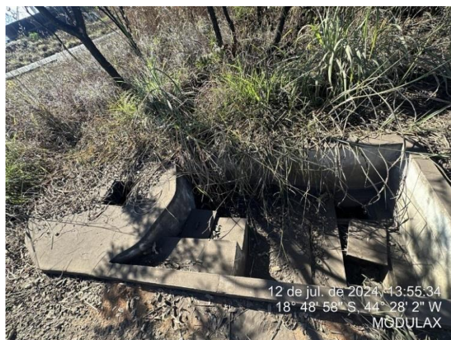
Foto 74: CSAO do Posto de combustível desativado.
