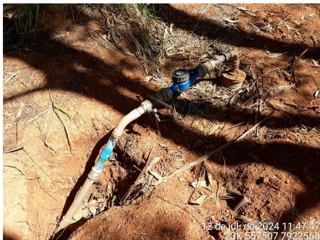
Foto 103: Hidrômetro do poço 03.
