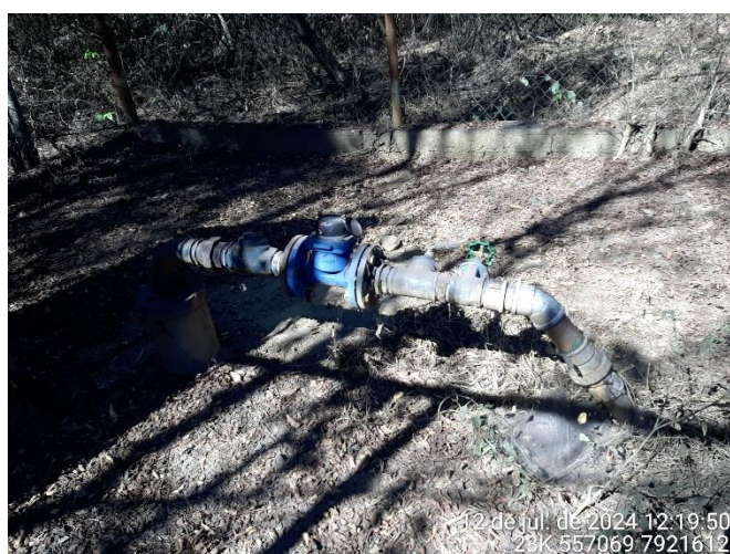
Foto 93: Poço artesiano 01 localizado no interior da reserva legal. Sedimento cobriu a placa de concreto construída ao redor do poço.
