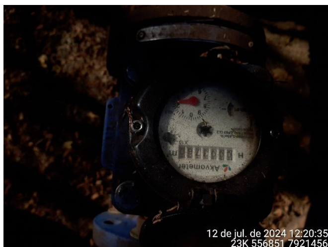
Foto 95: Hidrômetro do poço 01.
