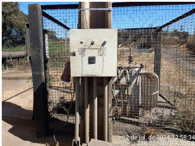
Foto 97: Horímetro do poço 01.
