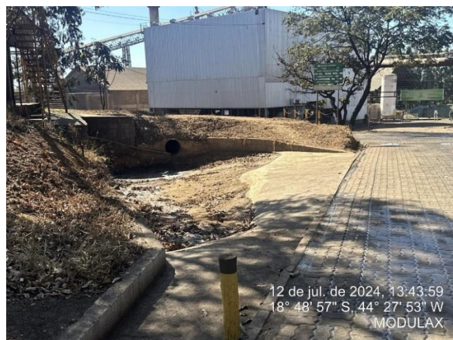
Foto 26: Canaleta de drenagem, com bacia de decantação associada
