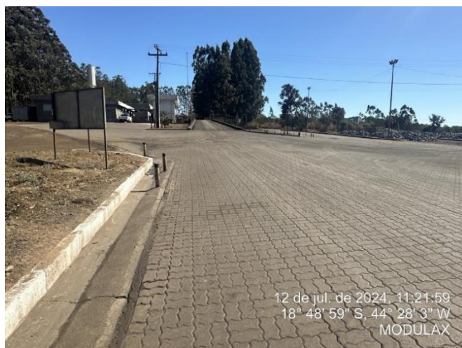
Foto 23: Vias de acesso as áreas da empresa, com a canaleta de drenagem associada
