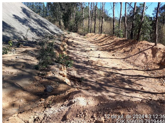
Foto 80: Direcionamento da drenagem superficial por meio de raspagem do terreno e formação de leiras ao redor da pilha de escória.
