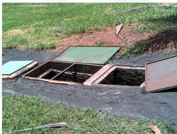
Caixa Separadora água e óleo – SAO.
