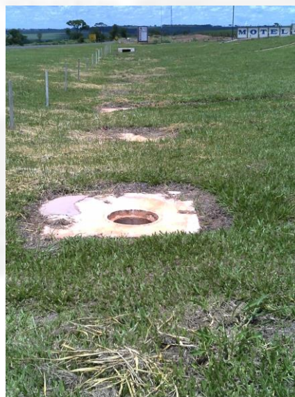
Rede de drenagem Pluvial caixas de passagem
