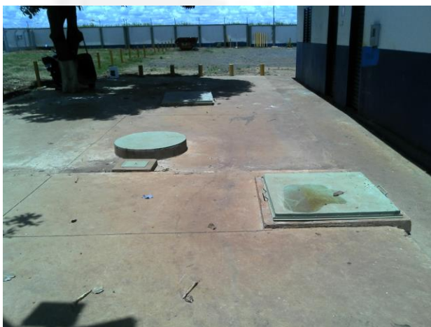
Pista de abastecimento com drenagem oleosa e drenagem pluvial
