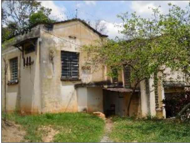
FOTO 07 – Casa de força.
