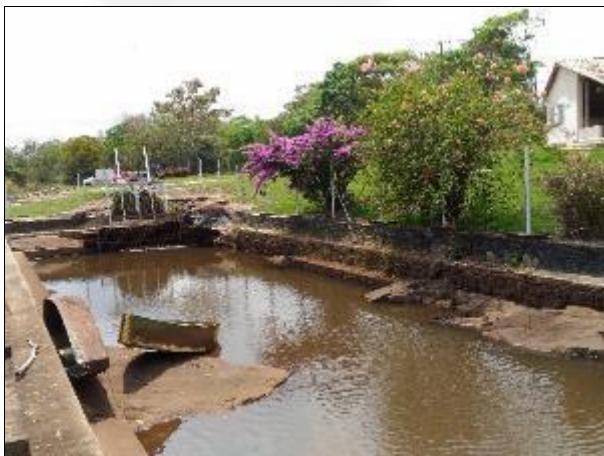
FOTO 05 – Entrada do canal de adução.
