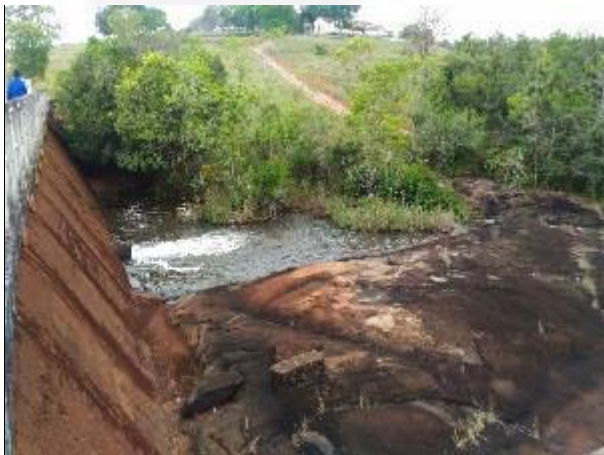
FOTO 03 – Barragem vista a jusante.
