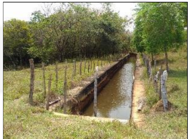
FOTO 06 – Canal de adução.
