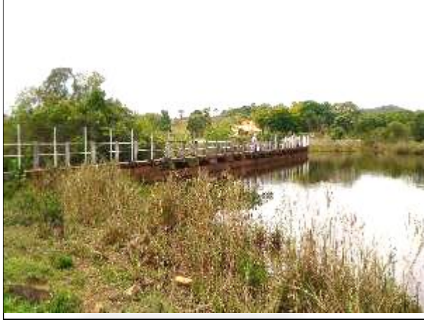
FOTO 01 – Barragem vista a montante.
