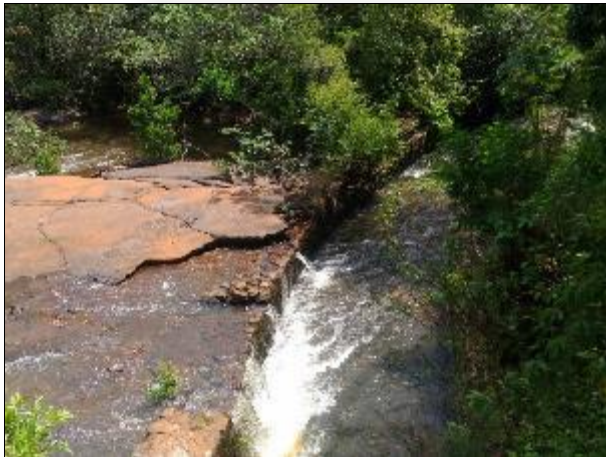
FOTO 09 – Trecho de vazão restituída.
