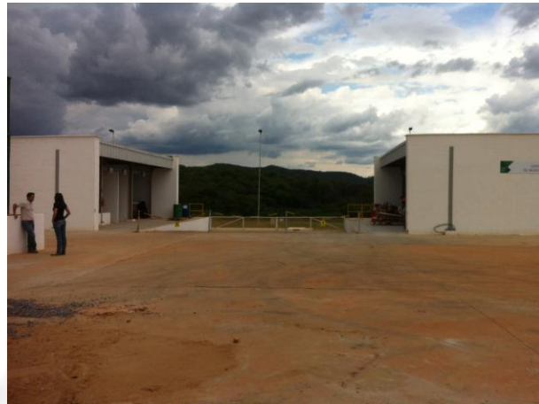
Imagem 17: Central de armazenamento de resíduos sólidos.
