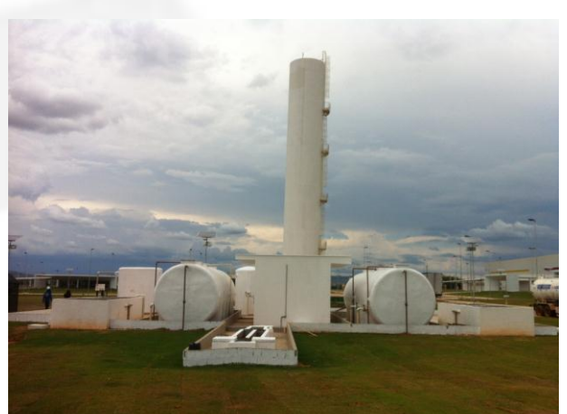
Imagem 16: Dique de contenção construído na ETE.
