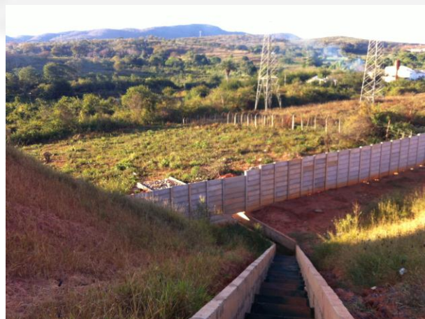
Imagem 19: Saída da rede de drenagem.
