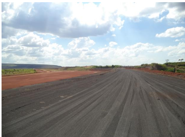
Foto 02. Ombreira direita na cota 1.220m
