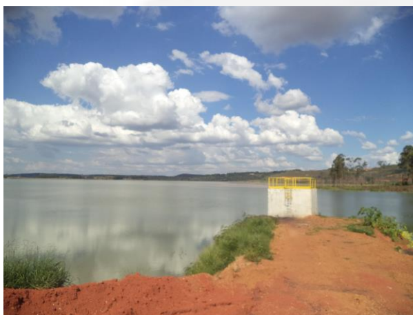
Foto 04. Torre extravasora na cota 1.220m
