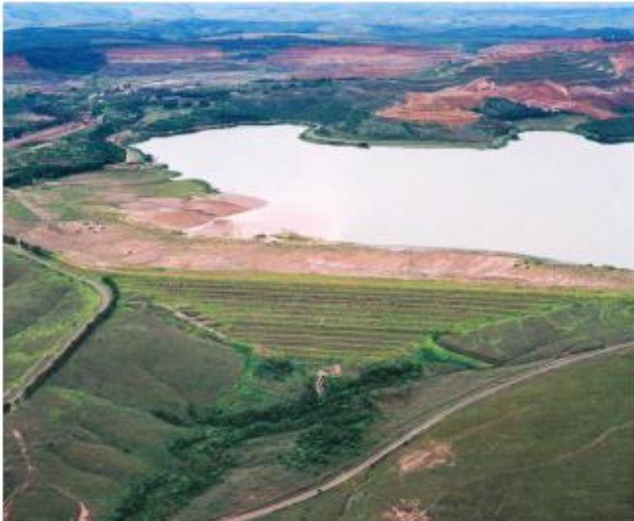
Foto 01. Visão da Barragem BL-1.
