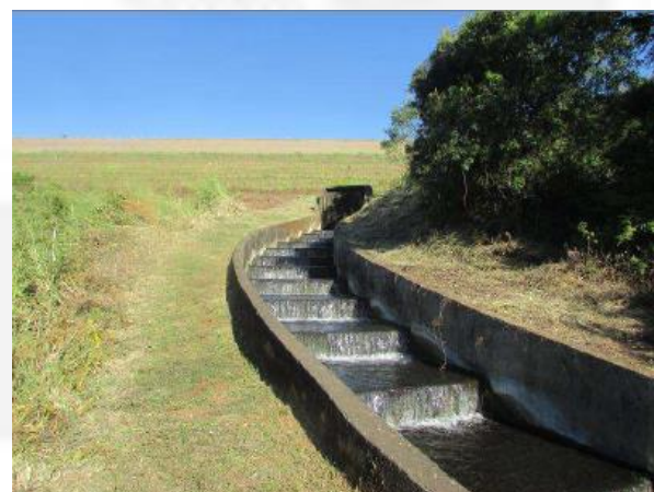
Fotos 06 e 07. Canal do dreno de fundo da barragem BL-1.
