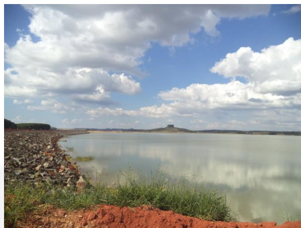
Foto 03. Ombreira esquerda na cota 1.220m
