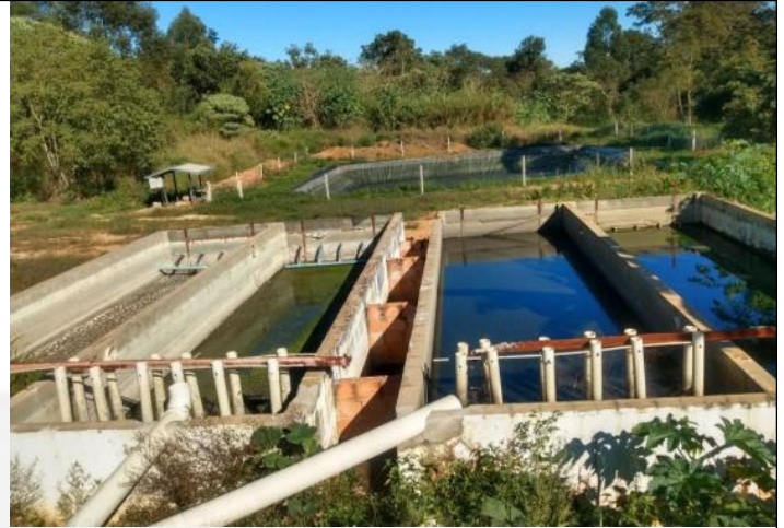
b) Caixas de decantação.
