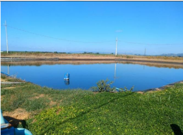
c) lagoa de estabilização
