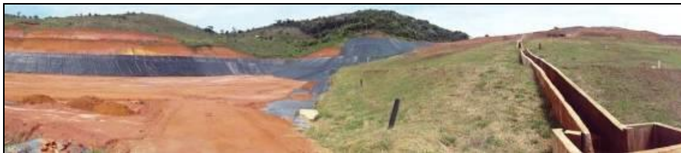
Vista frontal do aterro sanitário (jan/2015): À direita está a Fase 1, próximo da cota de encerramento; À esquerda está a Fase 2, sendo preparada para iniciar o recebimento de resíduos.
