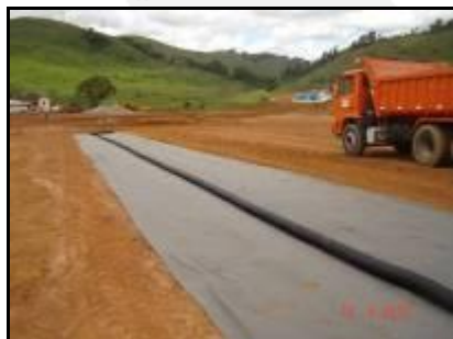
Implantação do sistema de drenagem de líquidos percolados (retirado de PARECER ÚNICO Nº 260282/2010 SUPRAM-ZM)
