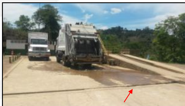
Área de lavagem, dotada de piso em concreto impermeável, circundado por canaletas interligadas à caixa SAO. A seta indica o ponto que necessita de reparo.
