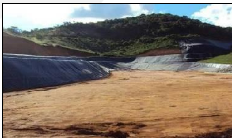
Impermeabilização da base e taludes mediante a compactação do solo e aplicação de geomembrana de PEAD.
