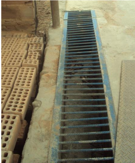
Foto 11: Canaletas de drenagem pluvial. Foto 12: Caixa de sedimentação (drenagem pluvial).
