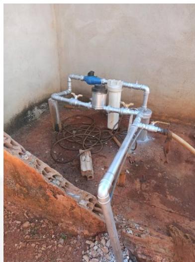
Foto 06 – Poço tubular
