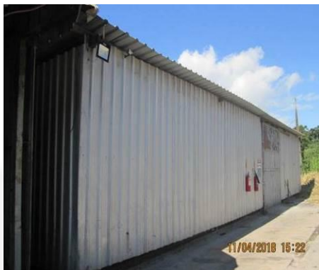
Figura 11: Depósito Temporário de Resíduos
