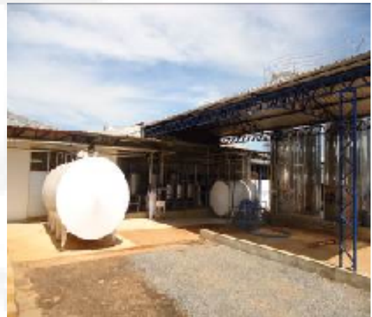
Foto 02. Área do pátio de recepção do leite.
