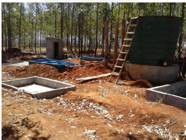
Foto 07. Obras para instalação da ETEI no momento da vistoria.
