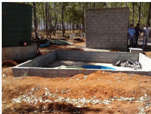
Foto 08. Obras para instalação da ETEI no momento da vistoria.
