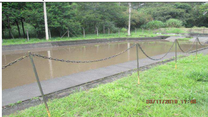
Foto 03: Vista da Caixa de Decantação para água pluvial
