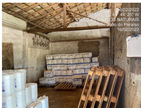
Foto 19 - Galpão de armazenamento de defensivos agrícolas.
