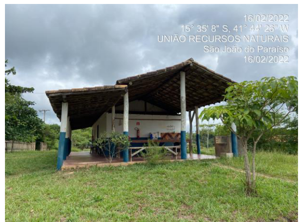
Foto 13 - Refeitório do empreendimento.
