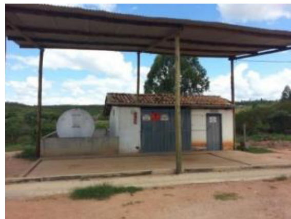
Foto 5 - Infraestrutura do tanque, instalado ao lado da pista de abastecimento.
