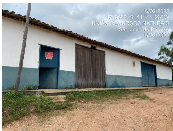
Foto 8 - Estrutura do galpão de armazenamento de produtos e resíduos oleosos.
