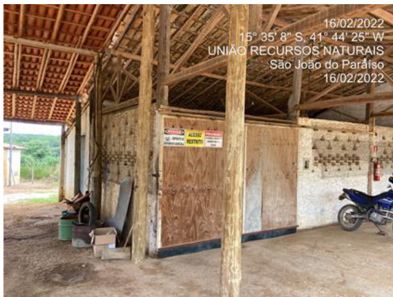
Foto 6 - Estrutura do galpão de armazenamento de produtos químicos.
