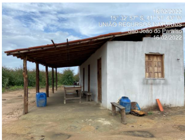
Foto 12 - Estrutura de apoio da praça de carvoejamento.
