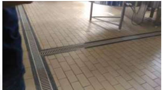
Figura 04: Canaletas no galpão de produção.
