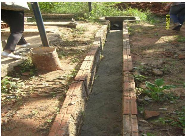
**Foto 05.** Sistema de drenagem pluvial
