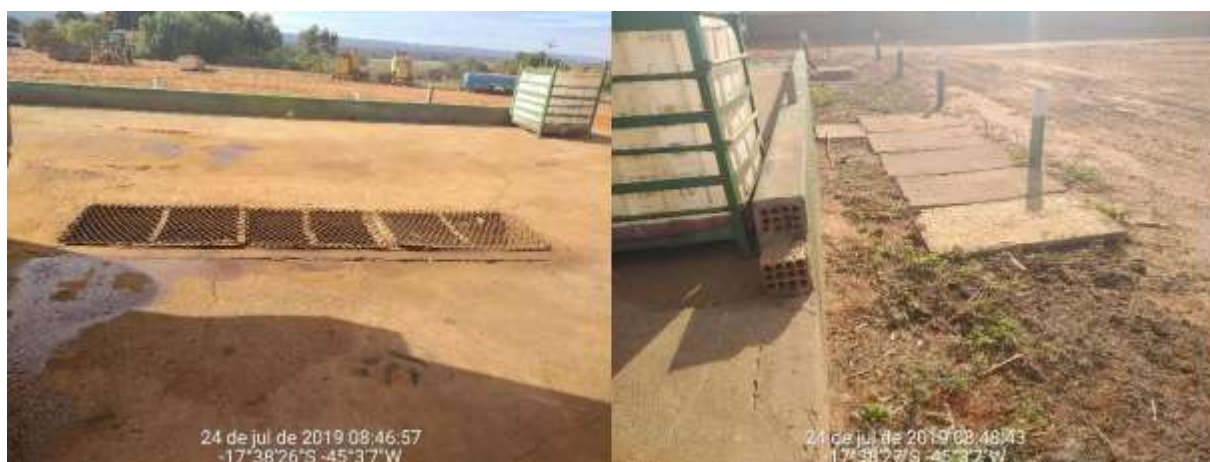
Figura 9. Coleta de efluente direcionada por declividade e caixa separadora de água e óleo.
