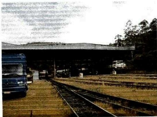
posto de abastecimento
