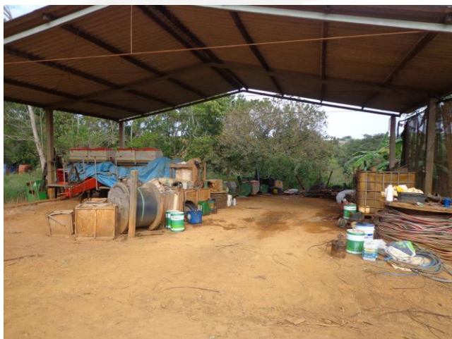
Figura 14- Barracão sem piso impermeabilizado
