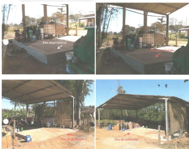
Figura 20- Adequações do piso do barracão (oficina)
