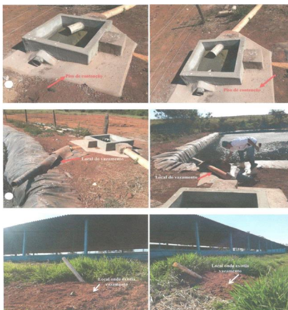
Figura 18- Adequações nos pontos de vazamento
