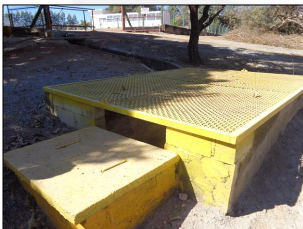
Figura 3: Caixa contenção – drenagem pluvial.
