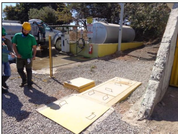
Figura 7: Ponto de abastecimento e caixa SAO nº 2.
