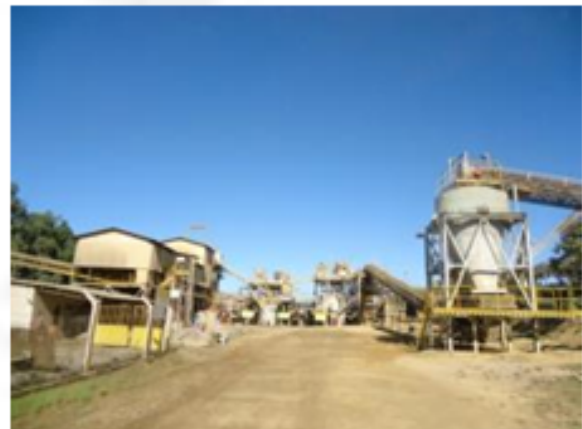
Foto 02. Unidade de Tratamento de Minerais - UTM
