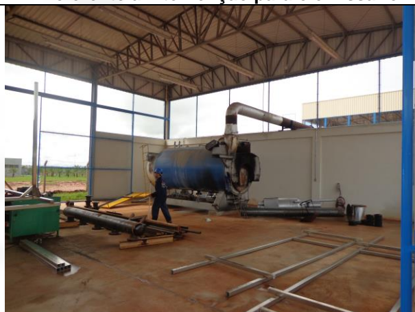
Figura 11- Montagem da Caldeira
