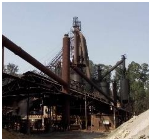
Foto 01. Forno e sistema de limpeza de gás.
